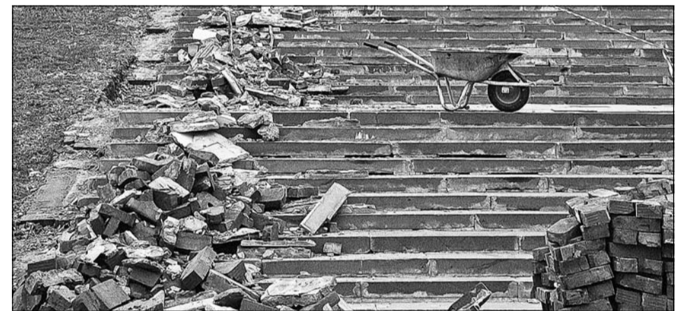
На ремонт городских лестниц из владимирского бюджета будет выделено около 4 млн рублей
