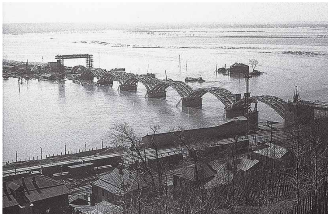
Во Владимире в 1955-1959 годах построен долгожданный арочный железобетонный мост через Клязьму. До этого веками использовалась наплавная переправа
