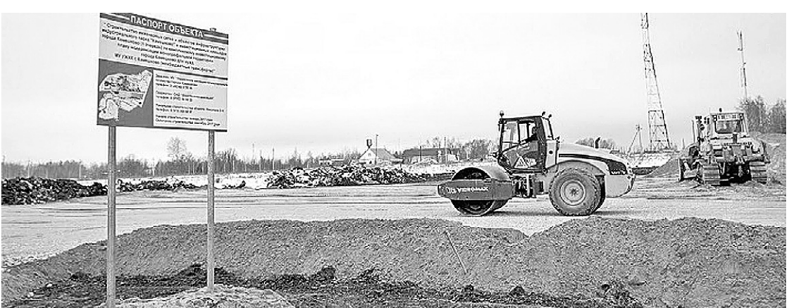
До 1 сентября инженерные сети и объекты промышленного парка «Камешково» должны быть построены.
